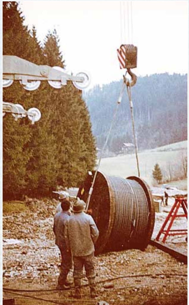
In der Bauphase der Blombergbahn: Lieferung des Förderseils mit einem Durchmesser von 32 mm und einer Länge von 3.600 Metern.
