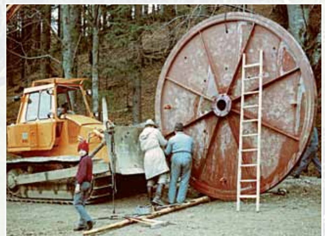
Transport der schweren Umlenkscheibe auf den Berg durch die Firma Thomas Hölzl
