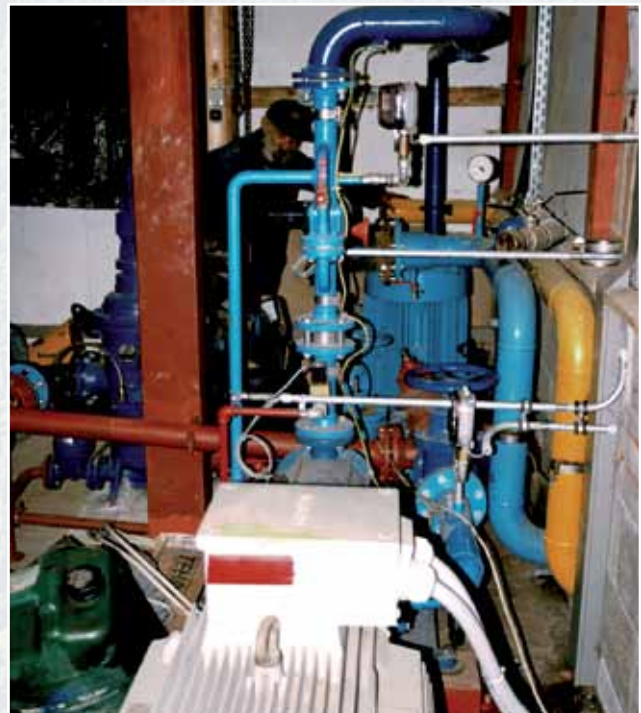
Die Pumpstation der Beschneigungsanlage, die seit 1976 immer wieder upgedatet wurde
